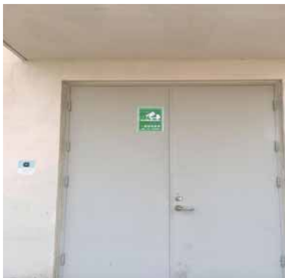
一般固废暂存间
